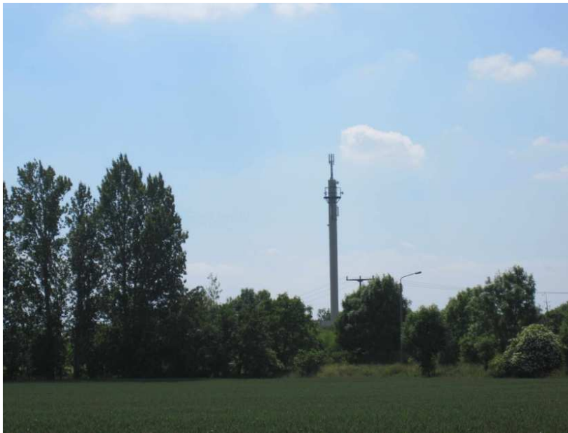
Abbildung 13: Feldflur Nauendorf -Blick auf den Mobilfunkmast
